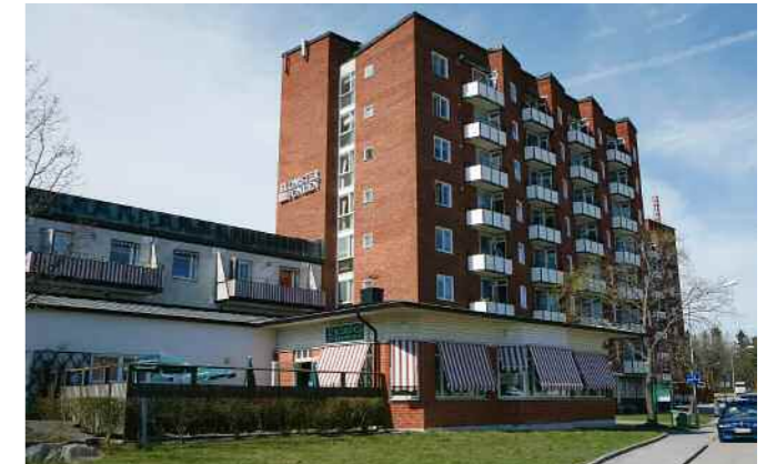
Liseberg i Älvsjö är en komplett anläggning med 373 lägenheter, sjukhem med 72 vårdplatser och restaurang i huset. De sju husen är från slutet av 50-talet och håller nu på att totalrenoveras för att leva upp till dagens krav.
